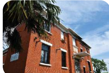
Maison des associations depuis février 2024 démarrage en janvier à la maison de quartier Maroc-Avenir
